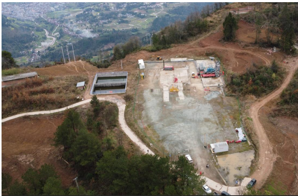
图 2.1-1 分 4 井场现场照片
