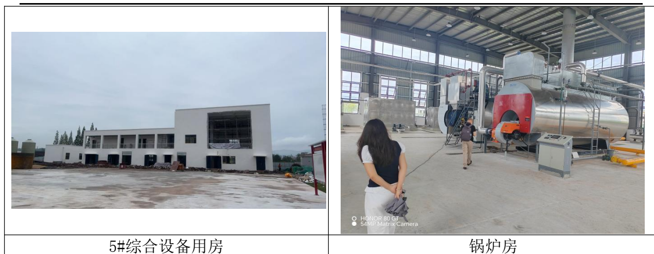
图2.8-1 项目现场建设情况
