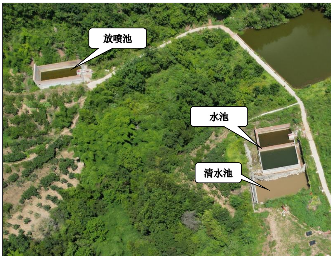
图 2.1-2 放喷池及清水池现场照片
