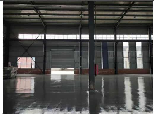
粉碎烘干车间地坪现状
