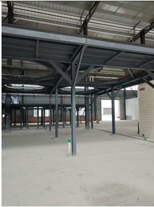
酸洗车间钢结构现状
