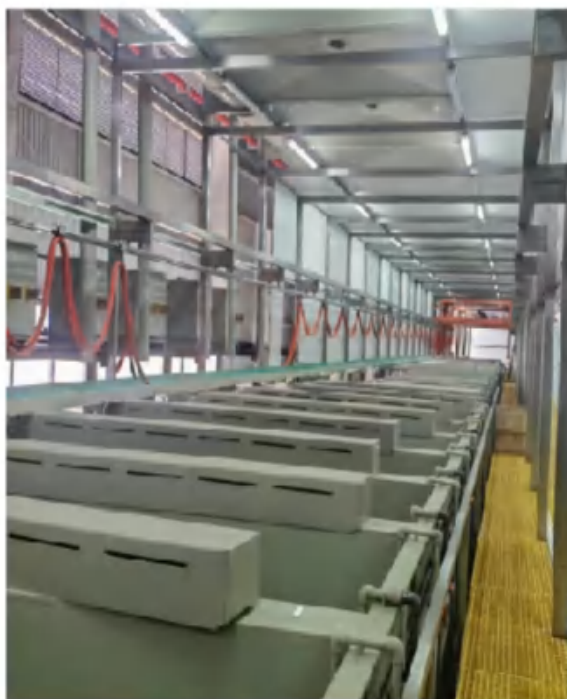
槽体侧边收集槽
