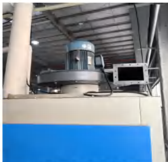
4#车间除尘器废气无组织排放
