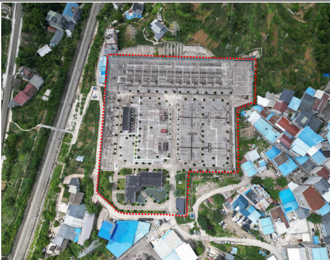
图 3-2 既有盖家坪 220kV 变电站现状（红色虚线为站界）
