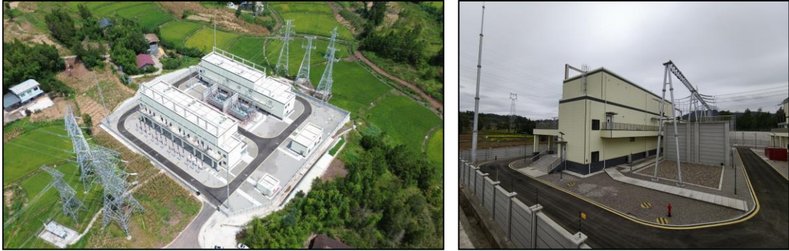
开江 220kV 变电站建设现状图
