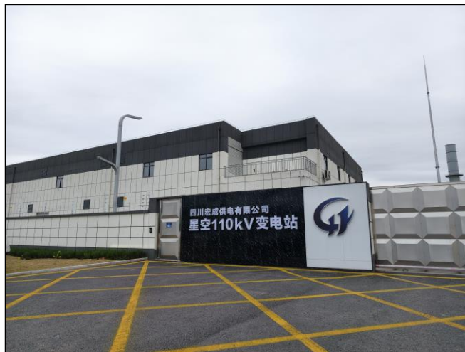
星空 110kV 变电站建设现状图
