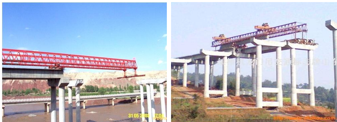
图 2.9-4 T 梁架设施工示意图
