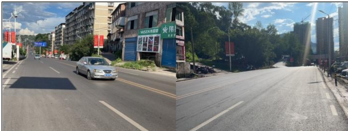
图 2.1-1 塔沱东路（谢生坝大桥张家坝岸桥头至加油站段）道路现状
