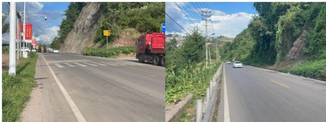
图 2.1-2 塔沱东路（加油站至保东寨段）道路现状
