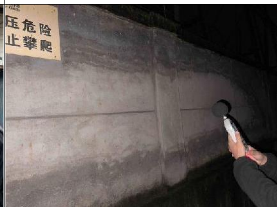
达州化工园220kV变电站噪声夜间监测
