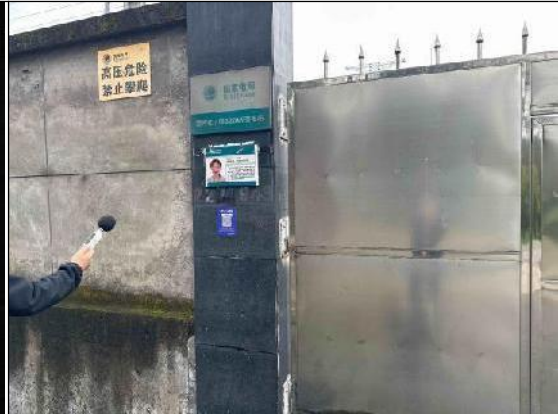
达州化工园220kV变电站噪声昼间监测
