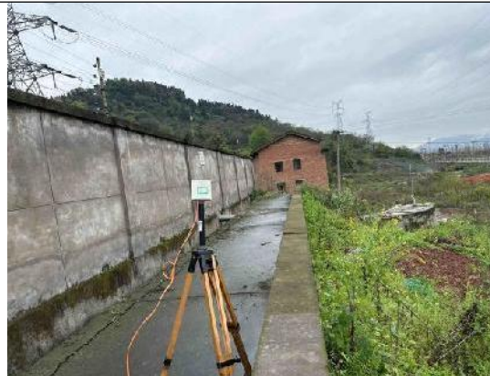
达州化工园220kV变电站厂界电磁监测
