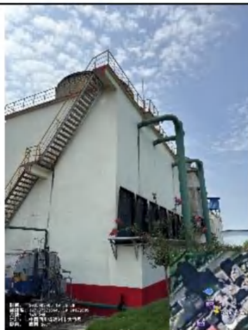
循环泵房及冷却塔
