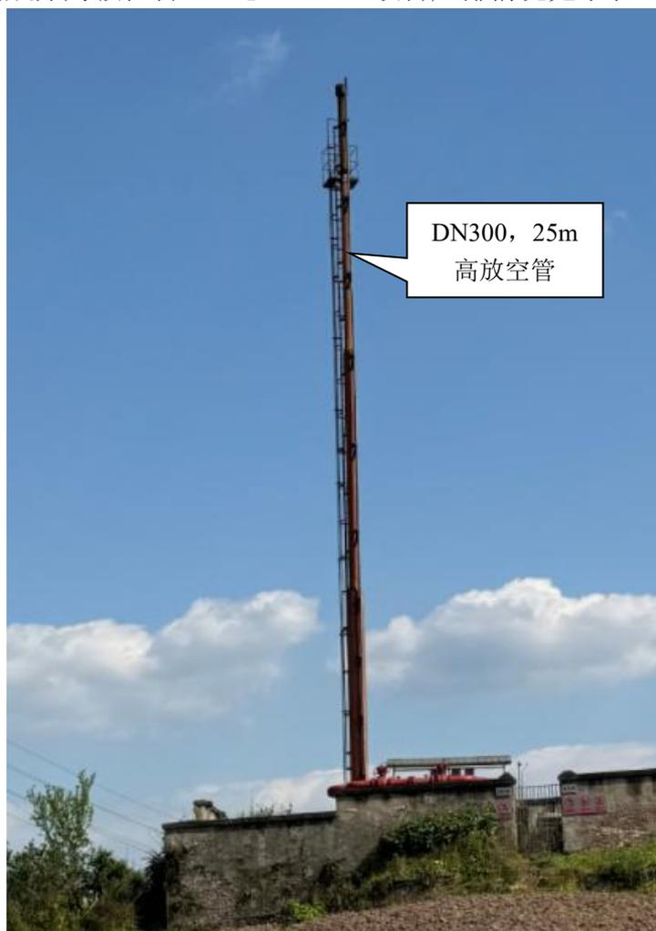
图 2.3-1 现有 DN300，25m 高放空管
