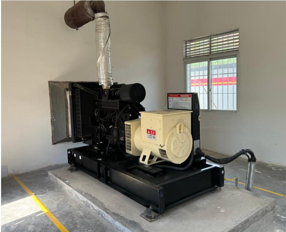
图 2.3-3 现有工程发电机房的备用柴油发电机
