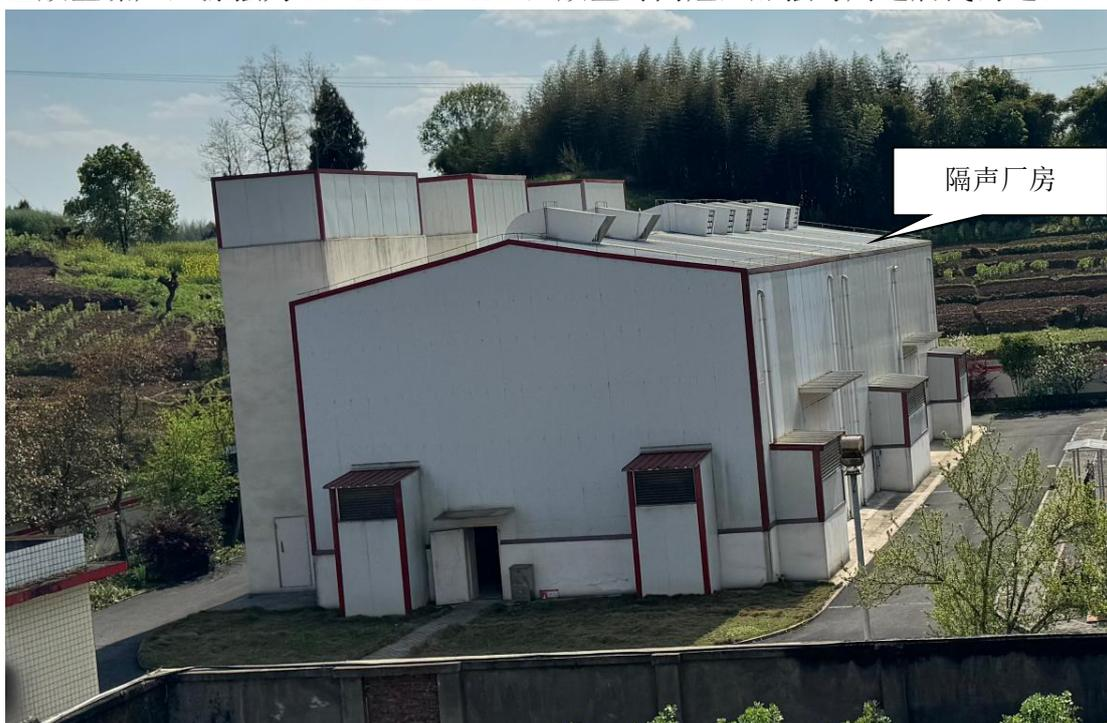
图 2.3-2 现有工程压缩机隔声厂房
