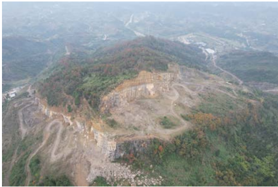
照片 1：项目矿区现状全貌
