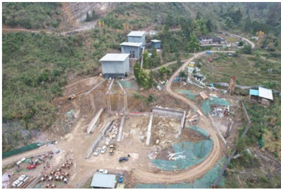
照片 1：项目拟建 2#加工厂现状（原豪翔矿业加工厂）
