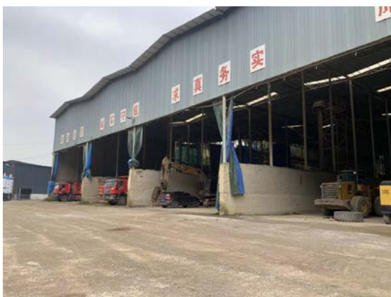
照片 5：项目拟建 1#加工厂现状（产品库运输车辆进出口）
