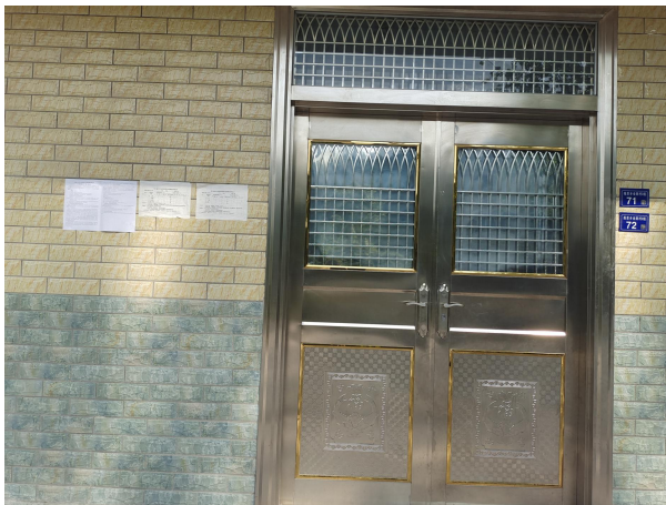
报恩乡（全胜村）居民房屋处
