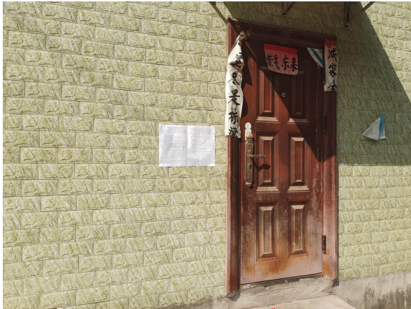
报恩乡（全胜村）居民房屋处
