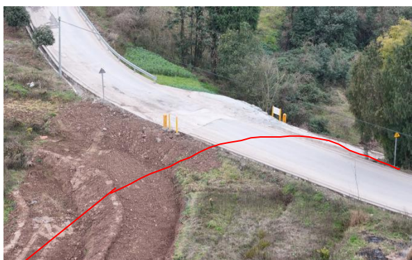
现场照片（管线穿越水泥乡道）
