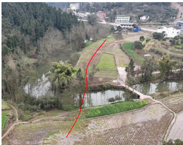
现场照片（管线穿越小河）
