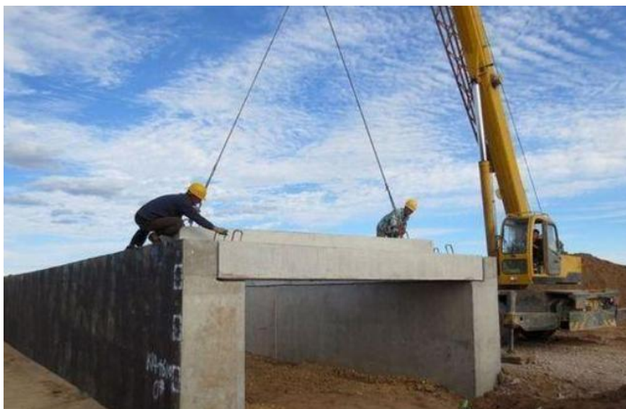
图 3-5 盖板涵施工示意图
