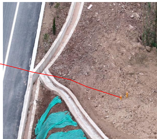
现场照片（管线穿越达开快速）
