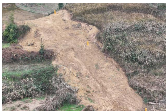
现场照片（管线穿越小山坡）
