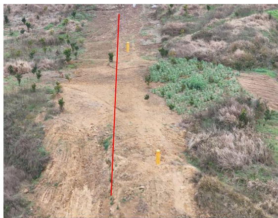
现场照片（管线走向）
