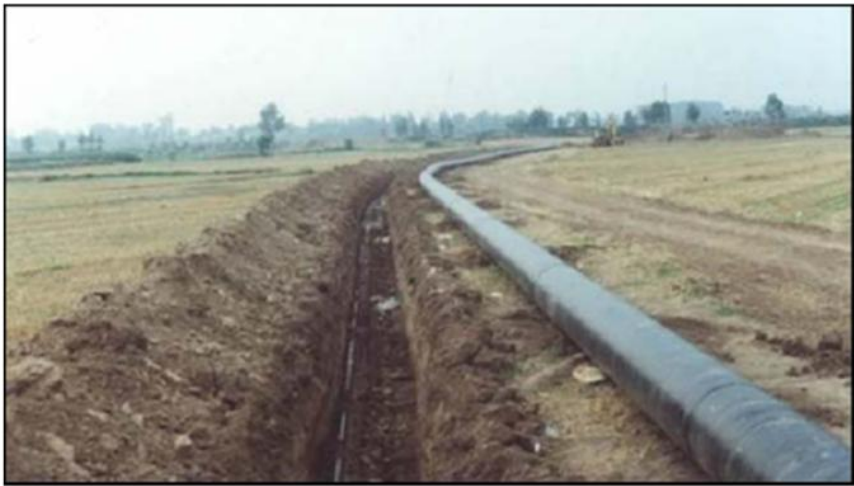
图 3-3 国内同类工程管线开挖实景图
