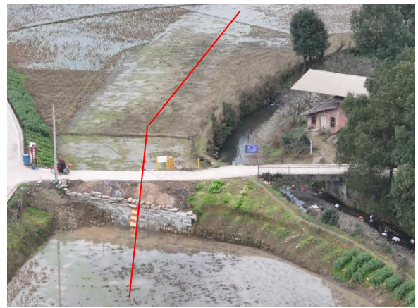
现场照片（管线穿越乡道）
