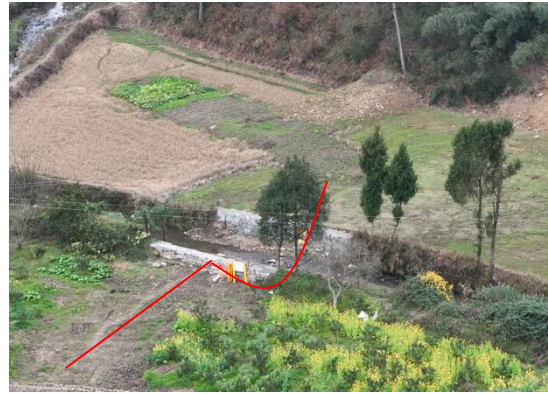
现场照片（管线穿越小河沟）
