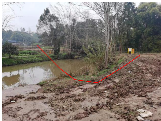
现场照片（定向钻穿越）
