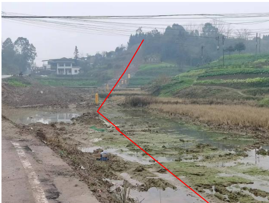
现场照片（管线走向）
