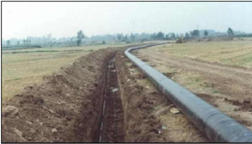
图 3-3 国内同类工程管线开挖实景图
