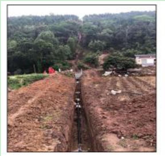
图 4.1-4 同类型管沟开挖及布管实景示意图
