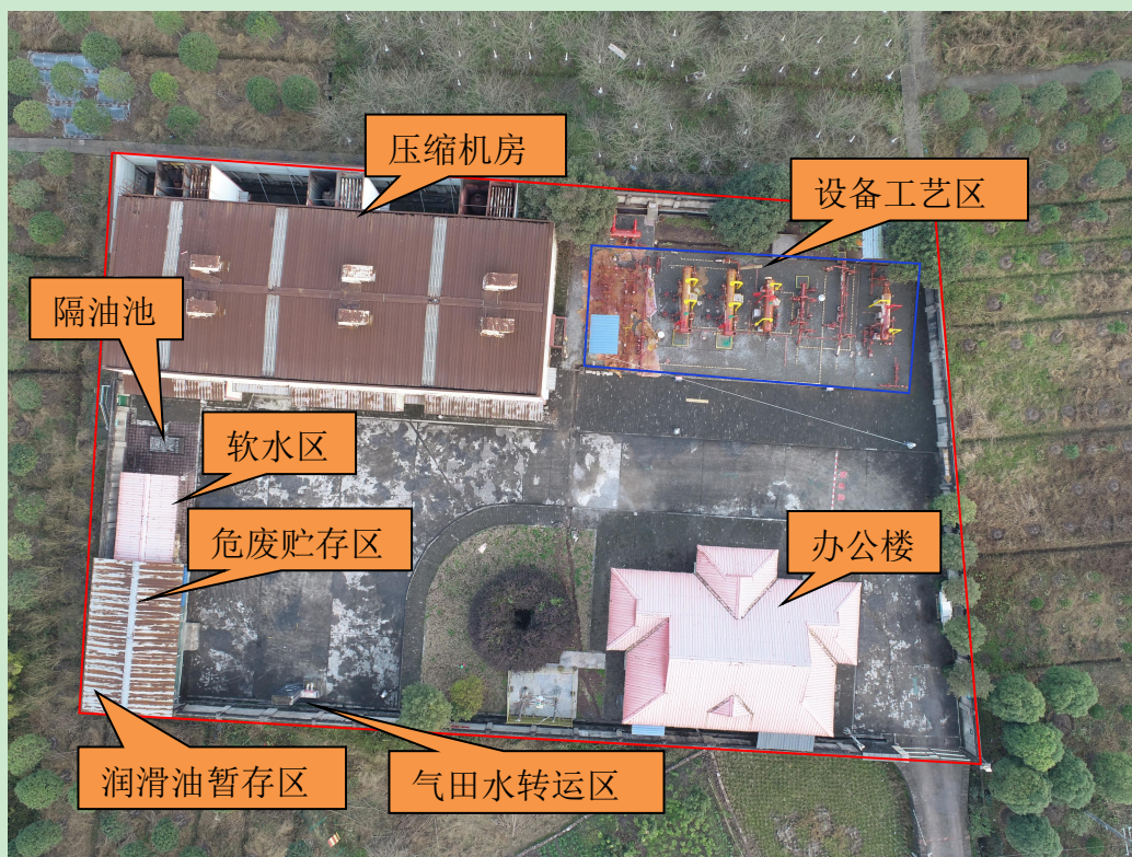
图 2-1 云和寨增压站站场现状图
