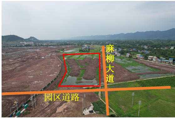
照片 1：项目区位置
