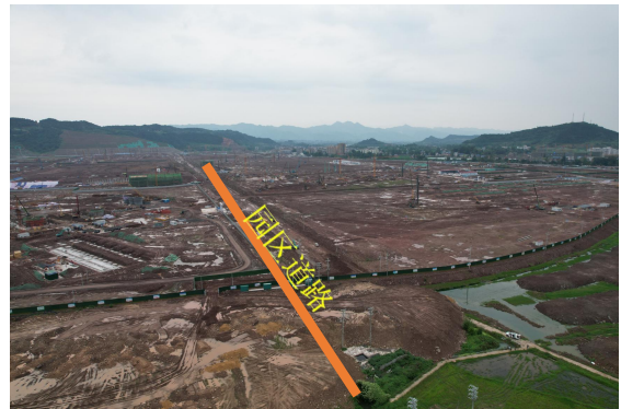
照片 2：项目区南面方大达钢建设区
