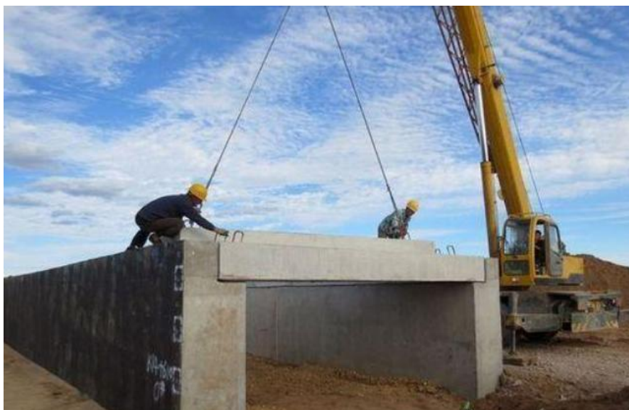
图 3-5 盖板涵施工示意图
