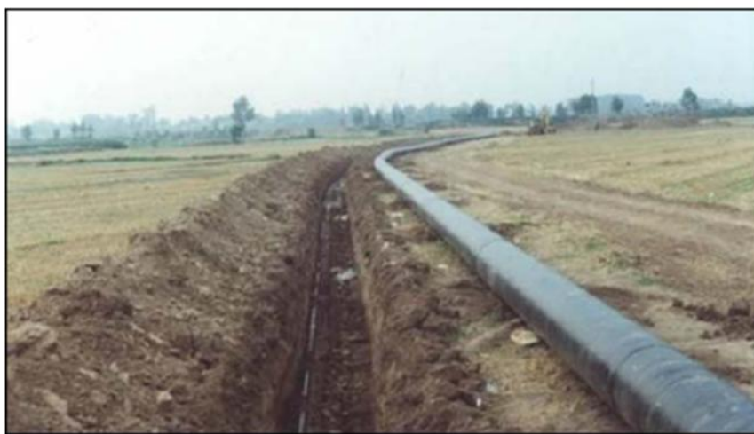
图 3-3 国内同类工程管线开挖实景图
