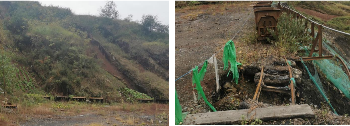
工业场地滑坡及塌方
