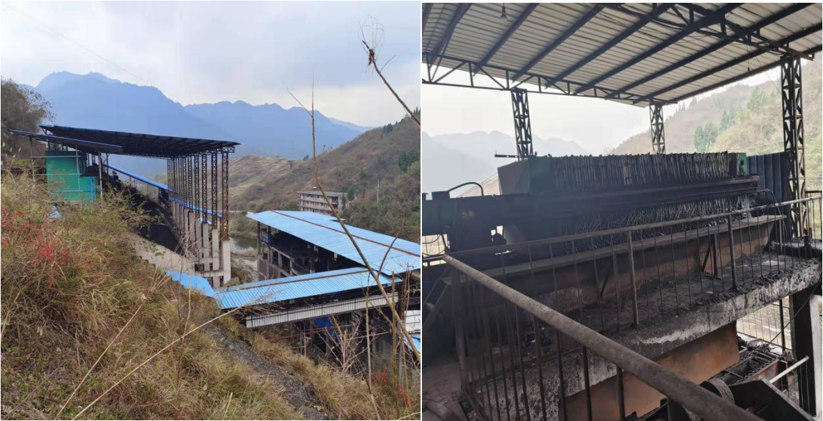
图 4.2-1 花草沟煤矿现状图（煤矿选煤厂）
