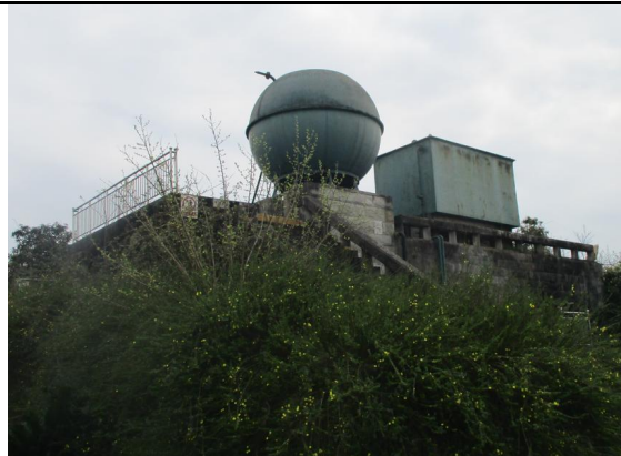
马家站气田水池
