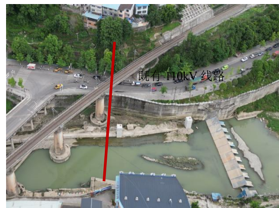
图 2-4 本工程拟增容线路跨越后河现状
