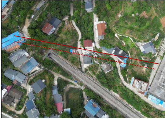
图 2-5 本工程 110kV 蕉坪线 170#~171#/110kV 官太线 24~25#塔之间跨越铁路现状（实线为拟增容线路）
