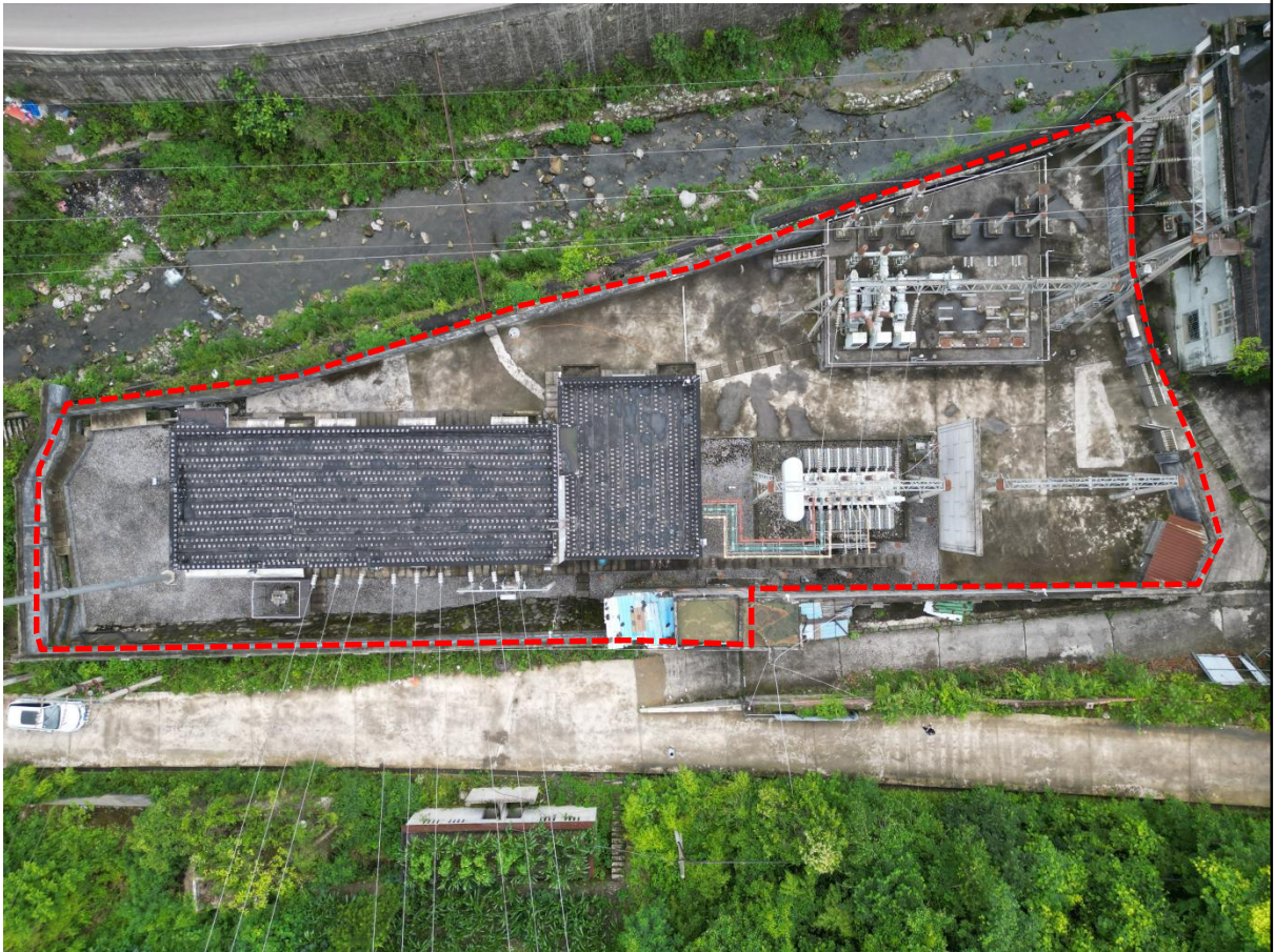
图 3-2 既有万源 110kV 变电站现状（红色虚线为站界）
