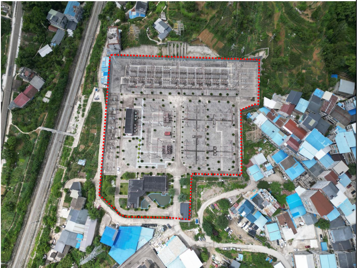
图 3-3 既有盖家坪 220kV 变电站现状（红色虚线为站界）
