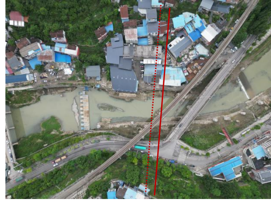
图 2-6 本工程 110kV 蕉坪线 167#~168#/110kV 官太线 21~22#塔之间跨越铁路现状（实线为拟增容线路）
