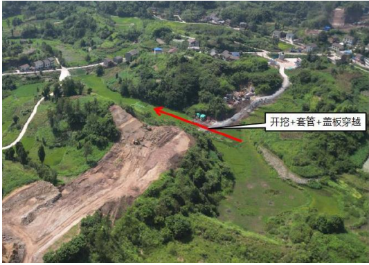
第二次开挖穿越在建渝西高铁现场图
