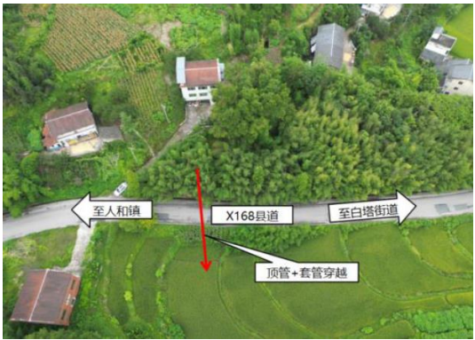
顶管穿越 X168 县道现场图
