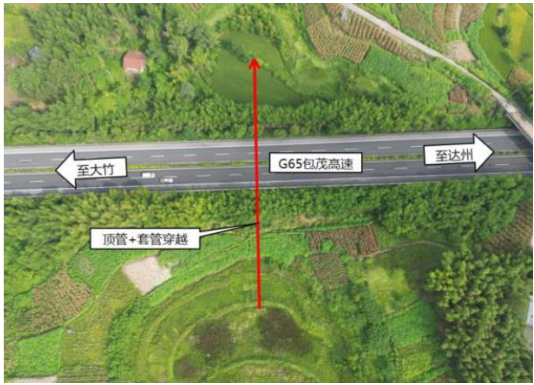
第一次顶管穿越 G86 包茂高速现场图
