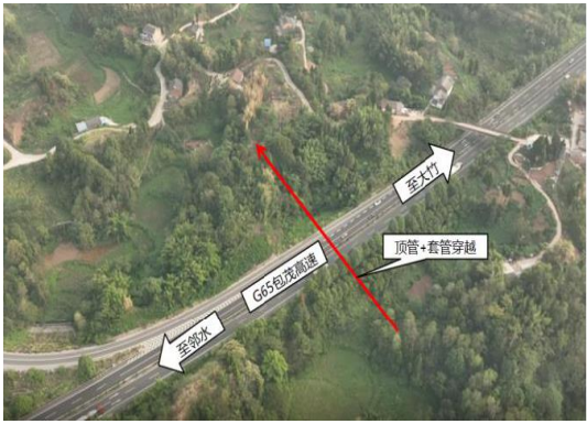
第二次顶管穿越 G65 包茂高速现场图
