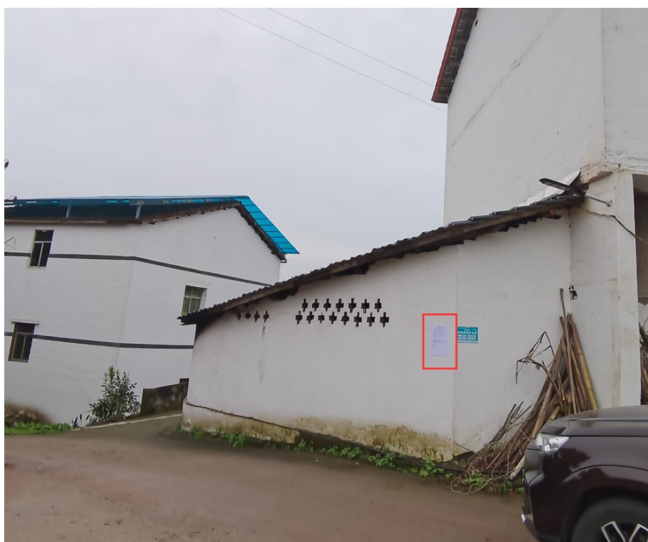
管道终点附近 (2023.10.8 ~2023.10.19)
