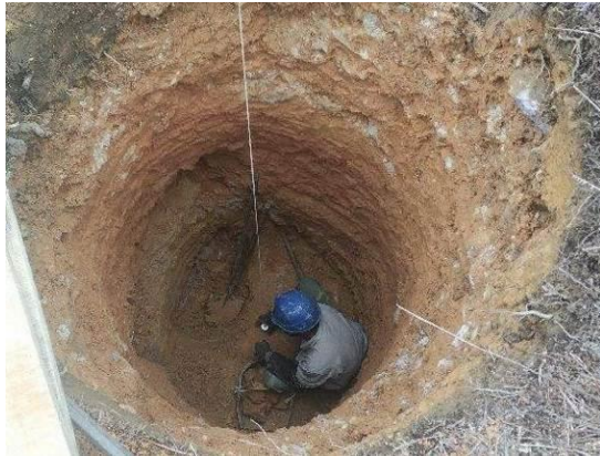
人工基础开挖
