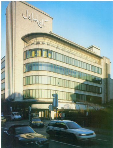
建筑楼身式招牌
