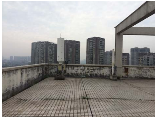
图 7-12 资阳市政府大楼基站
