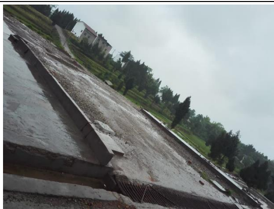
图 3.4-5 表土堆放场表土已挖方填埋
