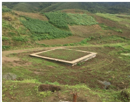
图 3.4-4 应急池已覆土
