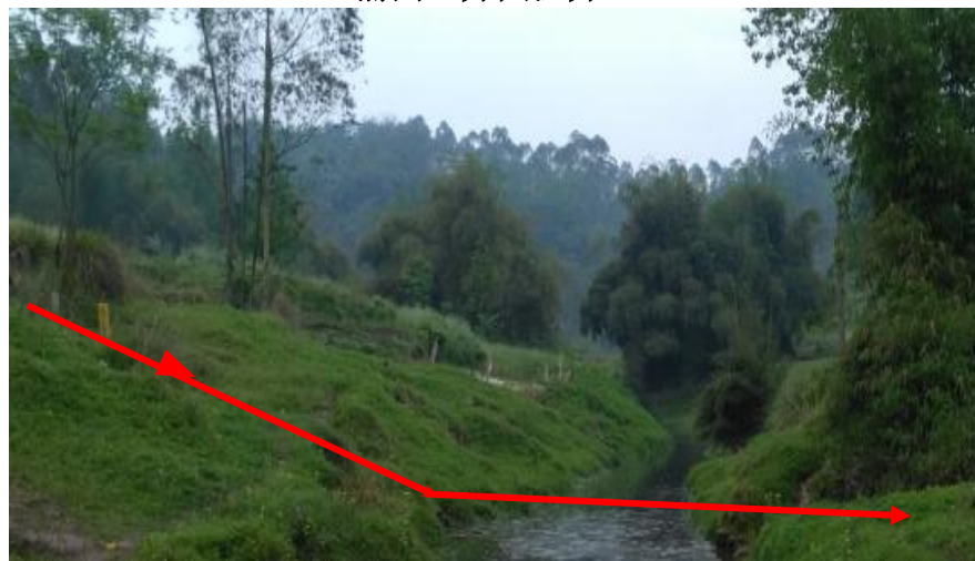
管线穿越小河沟现状
