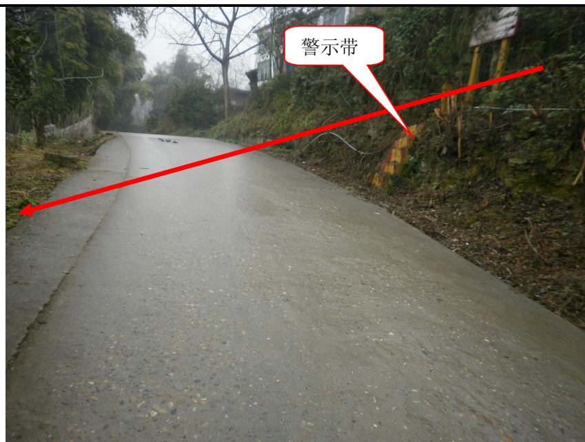
管线穿越乡村公路现状
