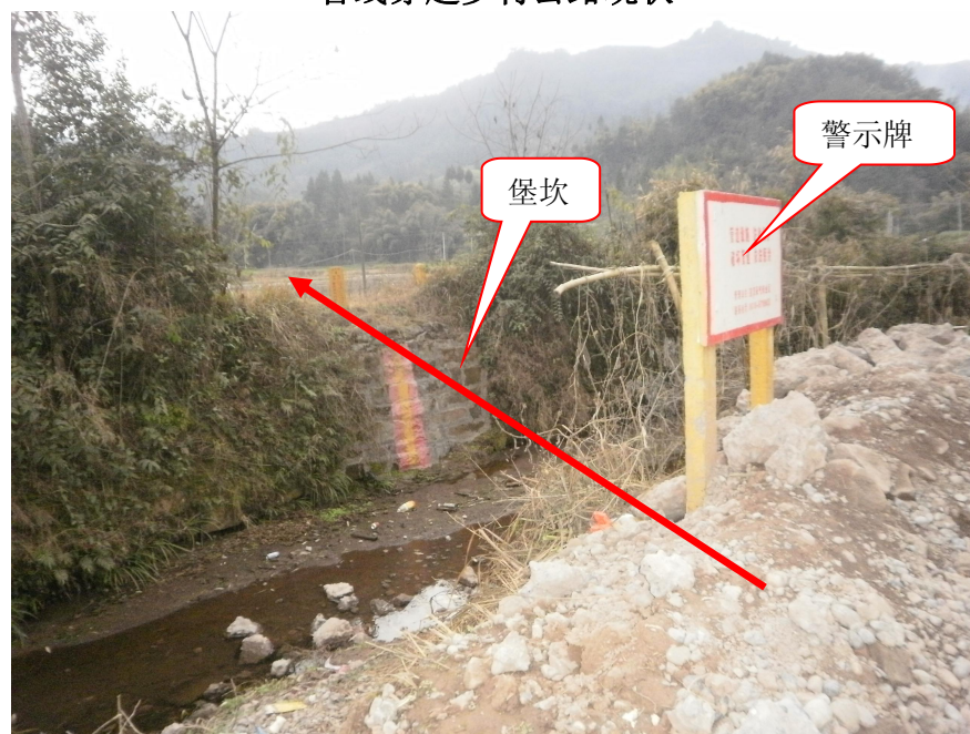
管线穿越小河沟现状
